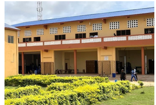
Neue Unterrichtsräume im 1. Stock über den Werkstätten
